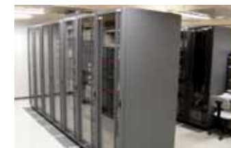
インターネットデータセンター(iDC) アプリケーションサービスプロバイダ(ASP)
