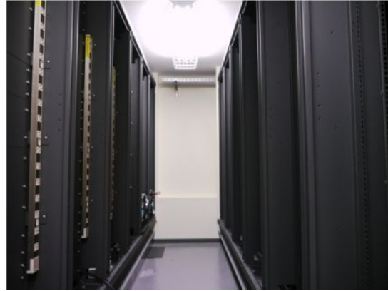
サーバールームラック
