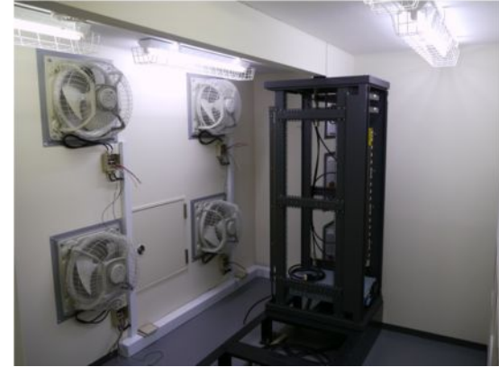
オペレーション室ラック
