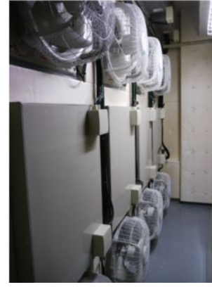
サーバールーム吸気ファン
